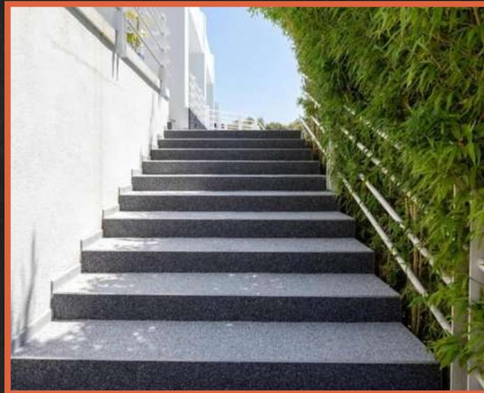
La Résine de Marbre ou Moquette de Pierre est un revêtement drainant et carrossable, c'est la solution parfaite pour une pose sur dalle béton ou sur graviers compactés afin de conserver la perméabilité des sols.
